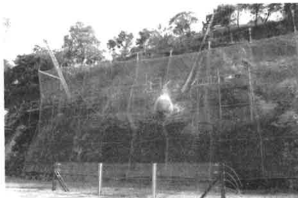
図6 高エネルギー吸収落石防護ネットの技術開発
