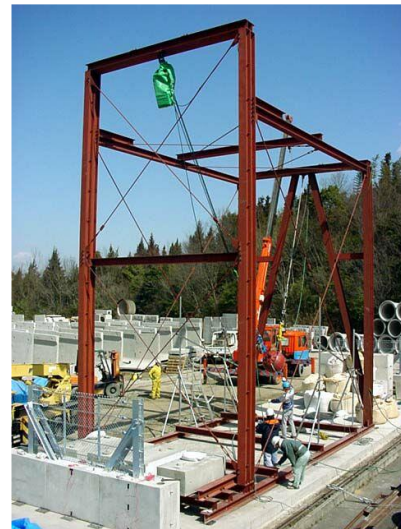
落石防護柵基礎の実物大実験
