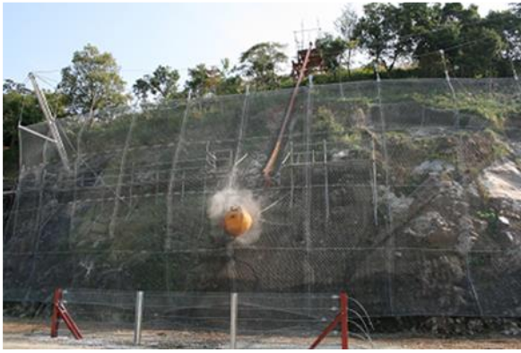
400kJの重錘を補足したロングスパン工法
