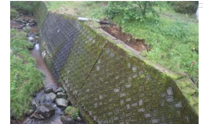
西原村 護岸擁壁
