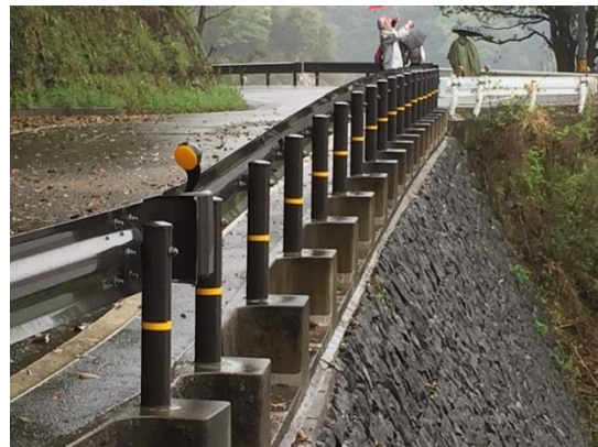
県道340号のガードレール基礎。これは私が平成10年に考案し、国から補助金をいただいで高知県コンクリート製品工業組合と共同で研究開発したコンクリート製品。
